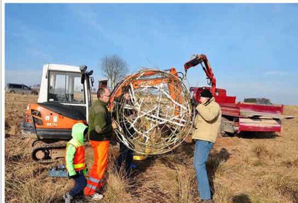
Der Korb wird an den neuen Storchmast im Arzbachtal zwischen Großseelheim und Schrück montiert. Rechts im Bild: Kirchhains Altbürgermeister Jochen Kirchner.
